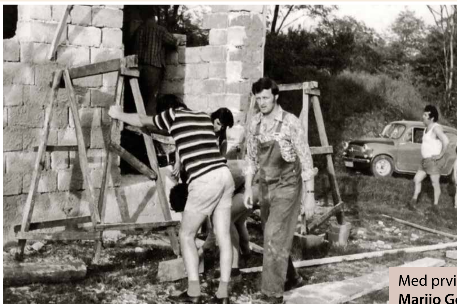
Začetek zidanja vaškega doma.
