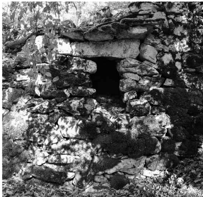
[20] Odprtina za spravilo orodja v škarpji v okolici Bazovice. F.: B. Čok
