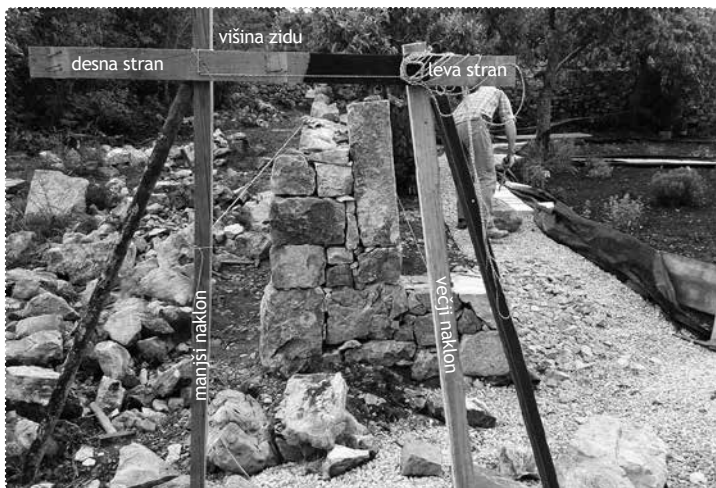
[9] Zakoličenje po dolžini, višini in nagibu pred koncem zidu. F.: B. Čok
