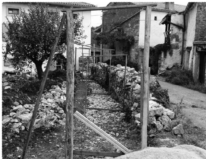
[8] Količenje po krivini, širini, višini in dolžini zidu za prezidavanje. Temelji so utrjeni pred količenjem. F.: B. Čok
