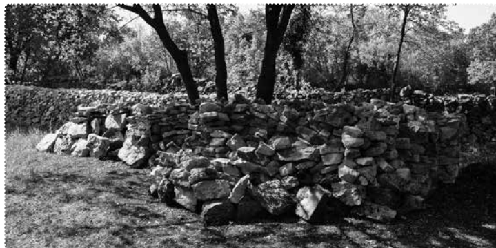
[5] Odbrano kamenje z licem in skrle. F.: B. Čok
