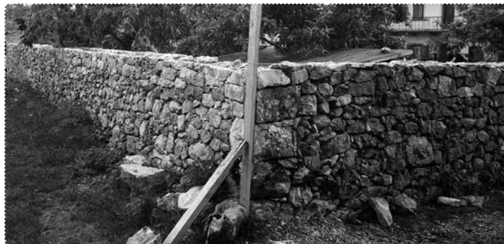
[17] Veliki vogalni kamni dajejo trdnost zidu na obeh straneh. Količek na vogalu se uporablja za nateg vrvice za višino zidu po dolžini. F.: B. Čok
