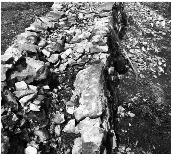
[16] Notranjost starega zidu je sestavljena iz nametanega drobirja, pri prezidavi pa se raje potrudimo ter drobir in kamenje lepo zložimo, da se bolje poveže. F.: B. Čok
