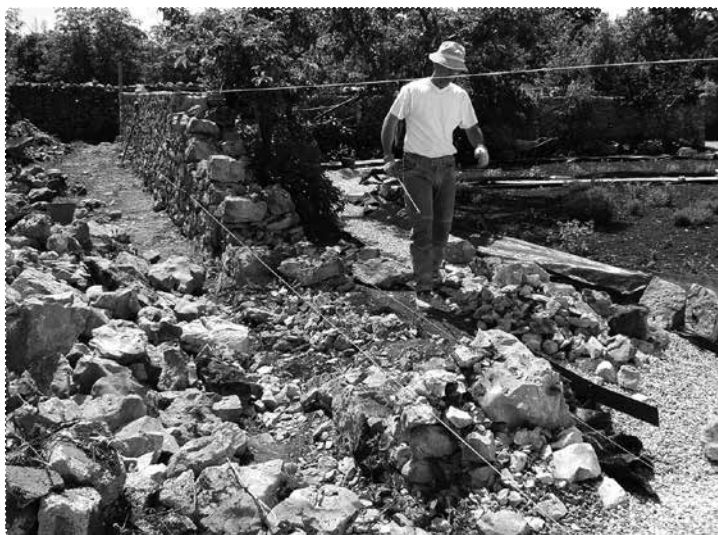
[4] Rušenje celotnega poškodovanega vrtnega zidu in priprava na pozidavo. F.: B. Čok
