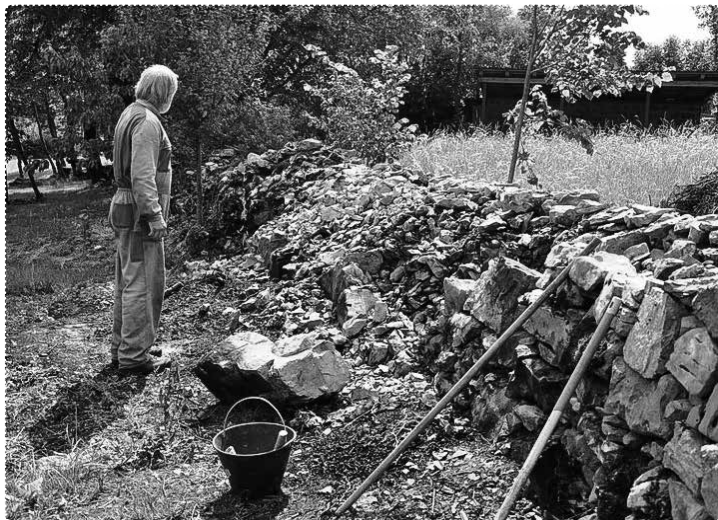
[3] Rušenje in popravilo samo ene strani zidu. F.: B. Čok
