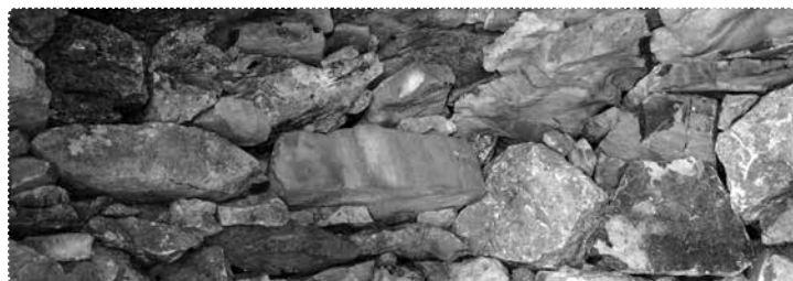
[25] Notranji velb. Lepo se vidijo manjše škalce, s katerimi podložimo skrle, da dobimo nagib navzven proti nosilnemu zidu. F.: Z. in D. Okoren
