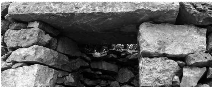
[19] Položimo ga nad vhod. V tem primeru sta bili položeni dve prekladi ena poleg druge. F.: Z. in D. Okoren
