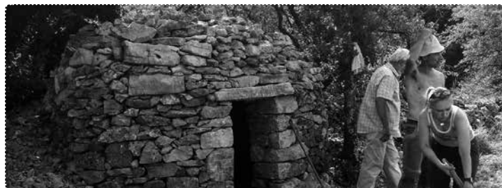
[24] Zaključevanje kupole. F.: Z. in D. Okoren
