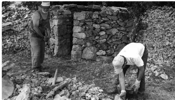
[16] Ko je obodni nosilni zid sezidan do predvidene višine, začnemo odbirati prve skrle za previsevanje strehe. F.: Z. in D. Okoren
