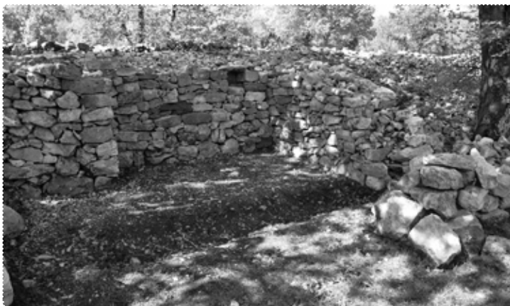
[12] Priprava temeljev za zid prislonjene hiške. F.: B. Čok
