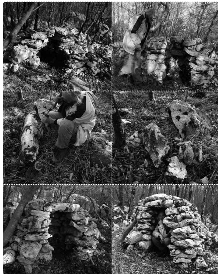
[6-11] Obnova hiške z enojnim zidom v Podlipah. F.: B. Čok
