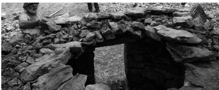
[21] Previsevanje nadaljujemo tudi prek obeh preklad, hkrati pa poravnavamo, glihamo z drobirjem, da bomo lahko polagali naslednjo vrsto skrl proti notranjosti, in zakladamo po zunanjem robu. F.: Z. in D. Okoren
