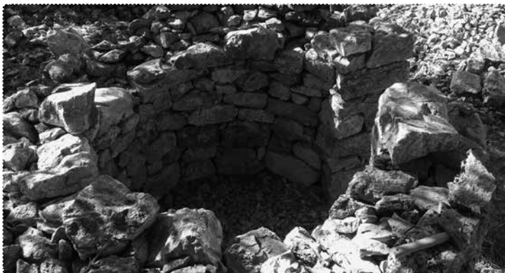
[15] Velika nosilnost zidu je zagotovljena z dobro izbranimi in vzdanimi kamni, enako pa velja tudi za skrbno polnjenje notranjosti zidu. F.: D. Okoren
