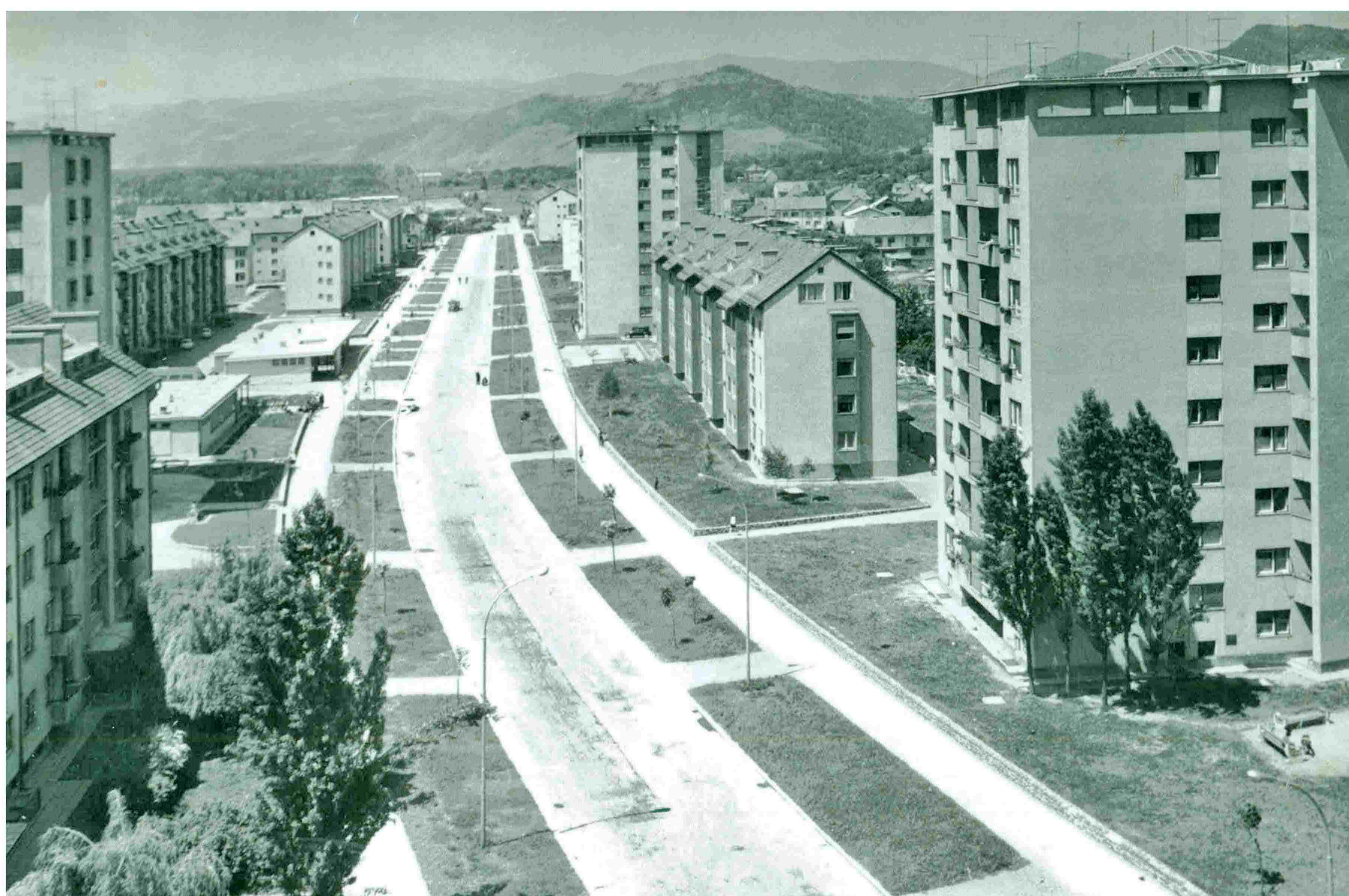
Pogled na Gosposvetsko cesto, foto Vončina, 1963
