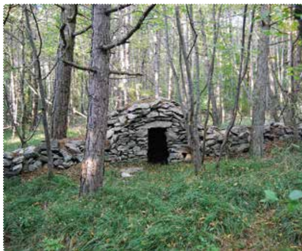
[33] Remonova hiška na Lišču pri Lokvi je vezana v nizkem zidu. Hiška je zidana na klasičen način z lepo vezanimi kamni ob stranicah vhoda, gurencem in visoko obokano streho v kupolo. F.: B. Čok
