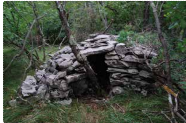
[49] Od drevesa poškodovana Mirčeva hiška nad Saravico pri Lokvi. F.: B. Čok
