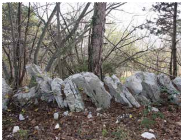
[6] Enojni zid iz pokončno nagnjenih kamnov pri Gropadi. F.: B. Čok
