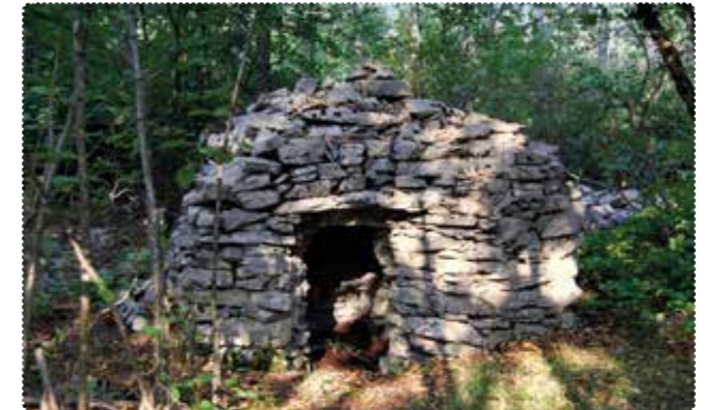
[30] Samostojna Jurčkova hiška na Mravah pri Lokvi je nekaj posebnega. Na zunaj je peterokotne oblike, znotraj pa kvadrataste z lepo velbano streho. Vhod je koničen in ima poleg gurenca še kap. Zgradil jo je pastir Jože Čok, po domače Pepi Jurčkov iz Lokve, in je ena od njegovih dvanajstih hišk, ki mu jih pripisujejo. F.: B. Čok
