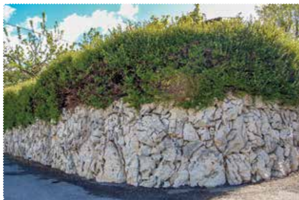
[52] Pretirana uporaba korozijsko izjedenih kamnin v zidu. F.: E. Belingar
