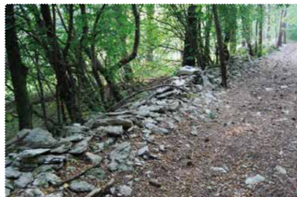
[50] Od izvlačanja borovih hlodov popolnoma uničen zid Čenčerukove ograde Obroženke pri Lokvi. F.: B. Čok
