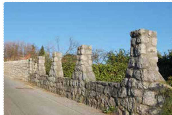
[54] Zid je zidan s kamenjem iz bližnjega opuščene kamnoloma, vendar z malto, s kamni, ki »ne ležijo«, in v obliki, ki nima nič skupnega s suhim kraškim zidom. F.: E. Belingar
