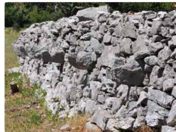
[12] Vinogradniški zid s kljukami ali legami za latnik Zabritof pri Lokvi. F.: B. Čok
