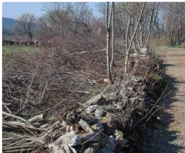
[48] Suh zid se je porušil zaradi bioerozije in nevzdrževanja. F.: M. Jeršek
