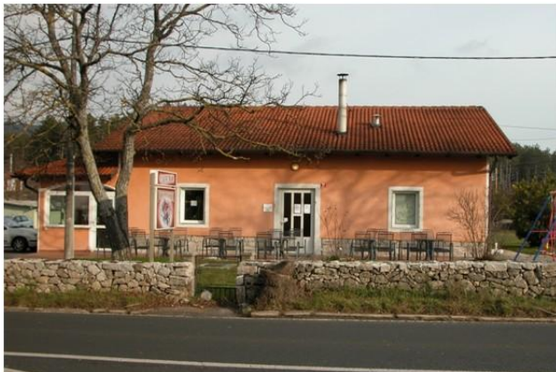
Slika 2: Obnovljena hiša Midretove bab'ce (fotografirali člani zgodovinskega krožka, februar 2011).
