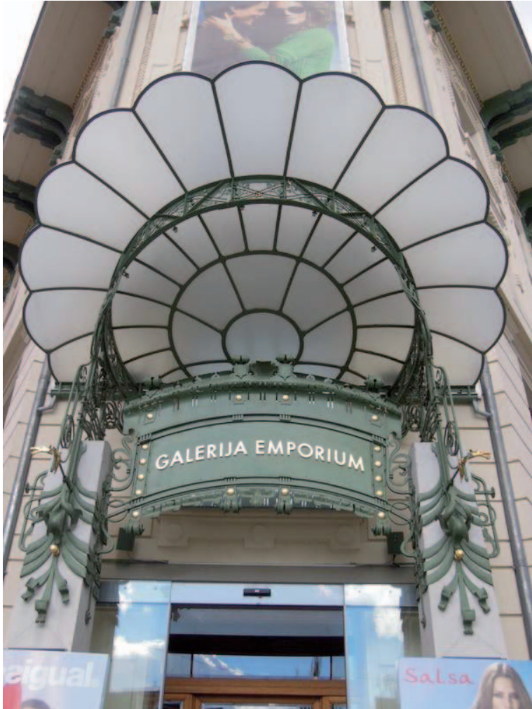
Nadstrešek nad glavnim vhodom
