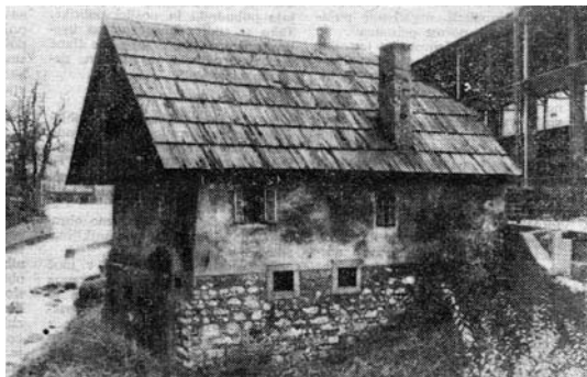
Stavba mlina v letu 1968. (GMJ)
