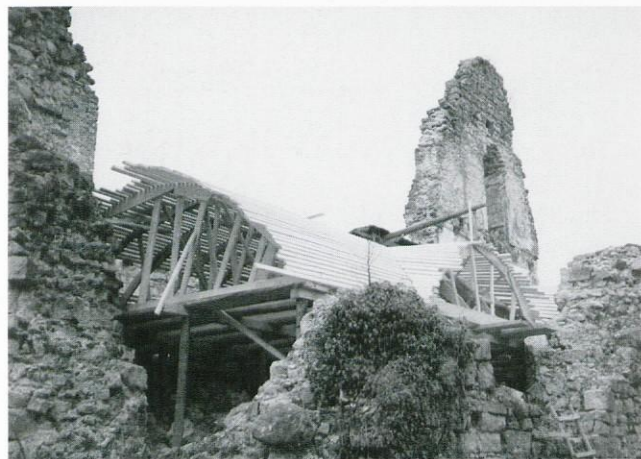
Obnavljanje obokov v vzhodnem delu palacija, 25. 4. 1997 (foto: L. Kerševan)
