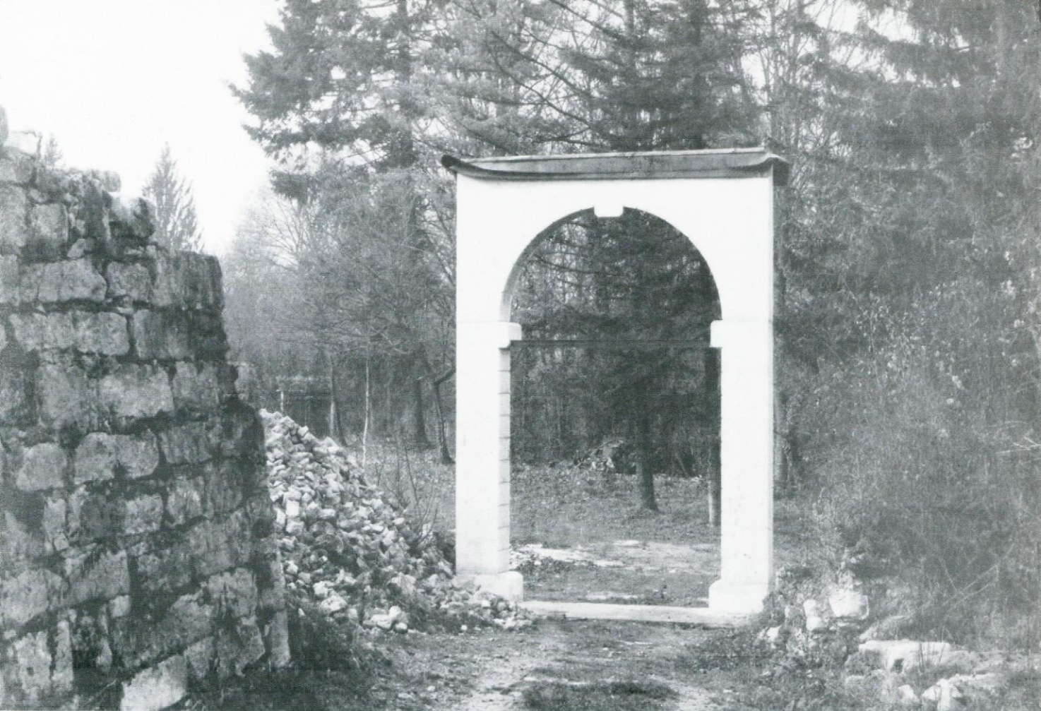
Portal iz dvoriščne strani po odstranitvi opaža (foto: M. Kapus)
