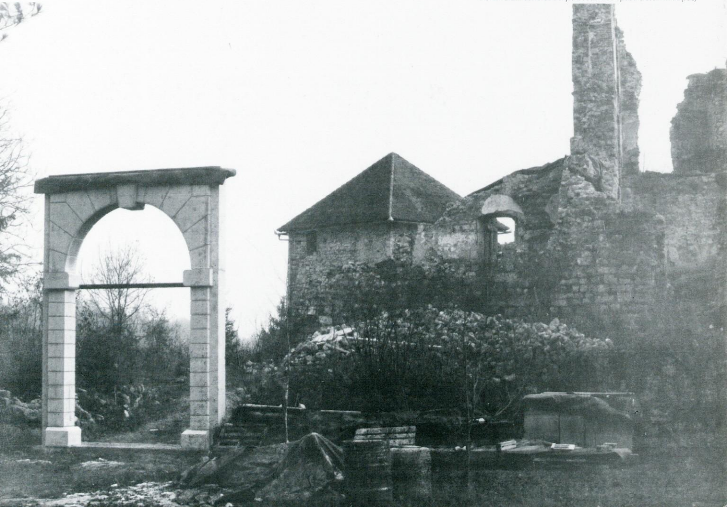
Portal iz zahodne strani po odstranitvi opaža (foto: M. Kapus)
