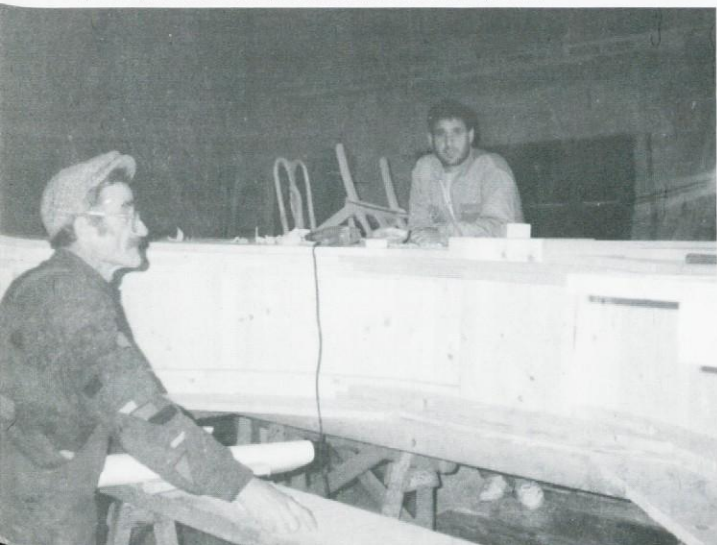
Priprava opaža za zahodni portal v delavnici Štefana Pepelnaka
