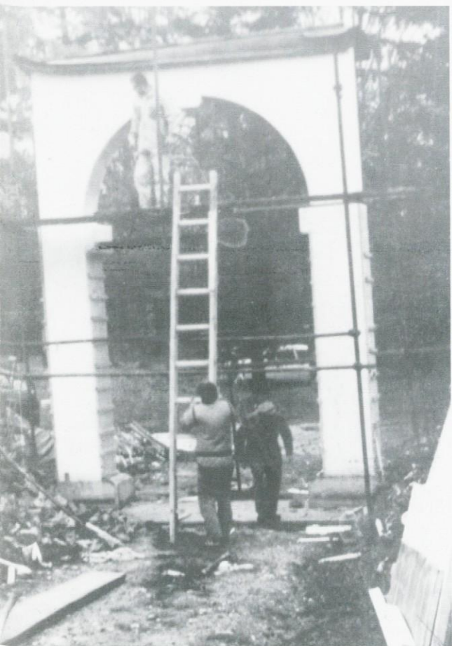
Priprava opaža za zahodni portal v delavnici Štefana Pepelnaka
