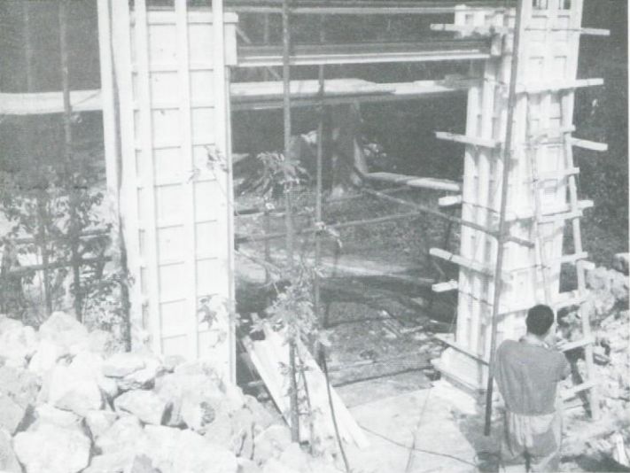
Postavljanje opaža zahodnega portala (foto L. Kerševan)
