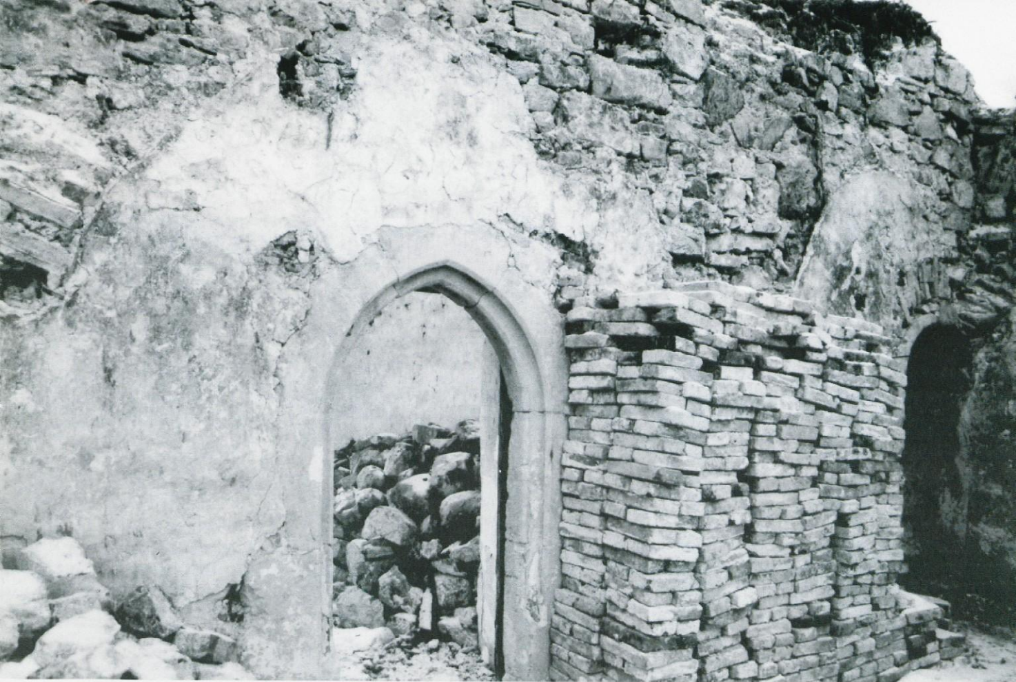
Predelna stena v vzhodnem delu palacija in dva srednjeveška vhoda (foto M. kapus)
