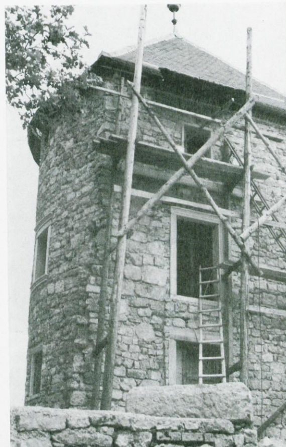
Polkrožni stolp pri obnavljanju renesančnega oboka (foto: A. Poklač)
