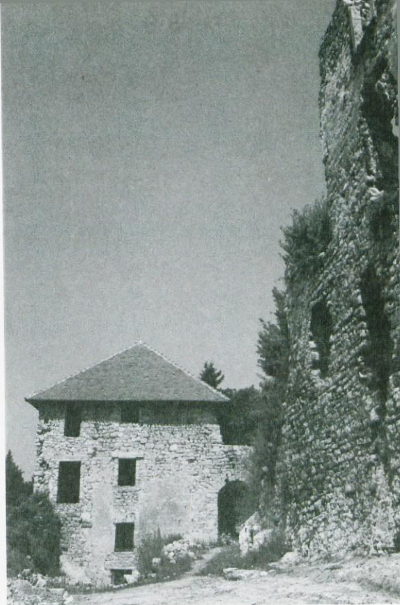
Pogled na del osrednjega dela pred čiščenjem (foto: A. Poklač)
