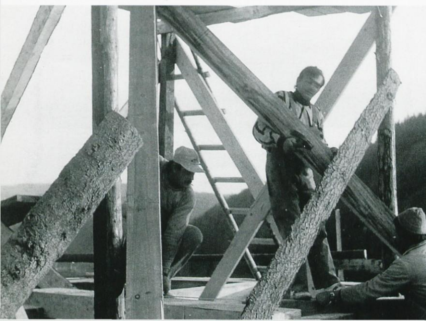
Zgoraj, v sredini in spodaj: Obnavljanje strehe na jugovzhodnem stolpu Mirenskega gradu, v januarju leta 1994, foto: S. Kerševan
