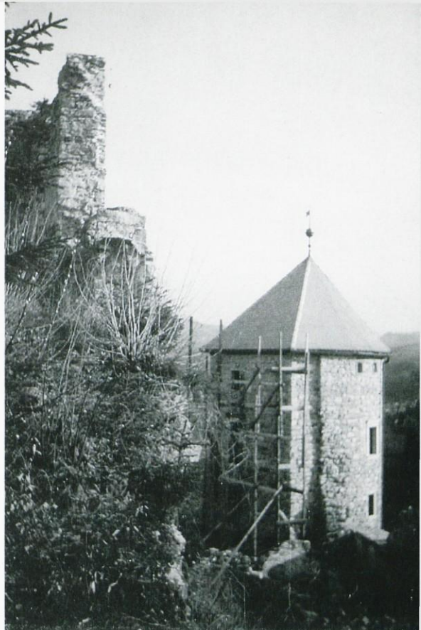
Severozahodna podoba obnovljenega jugovzhodnega stolpa, foto: H. Cugelj
