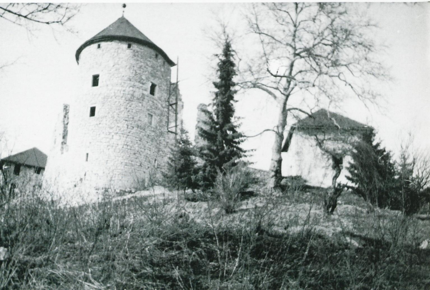
Jugovzhodni stolp po končani obnovi januarja 1994, foto: H. Cugelj
