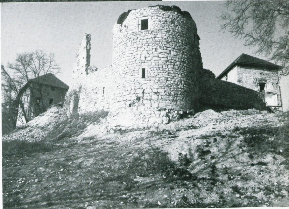
Obnova jugovzhodnega polkrožnega stolpa v letu 1992 Foto: M. Kapus
