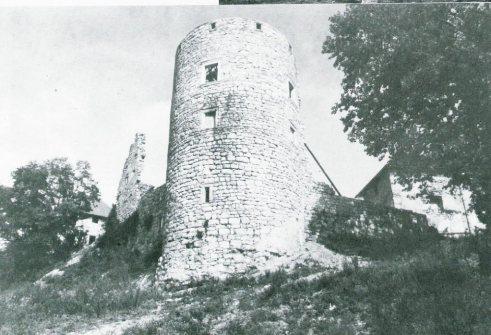
Obnova jugovzhodnega polkrožnega stolpa v letu 1993 Foto: M. Kapus
