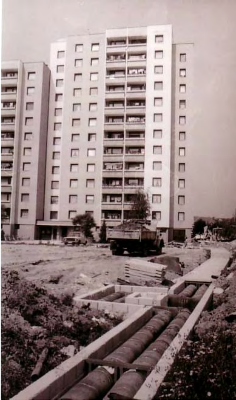
Fotografija 7: Gradnja kanalizacije na Zgornji Hudinji konec 70-ih let
