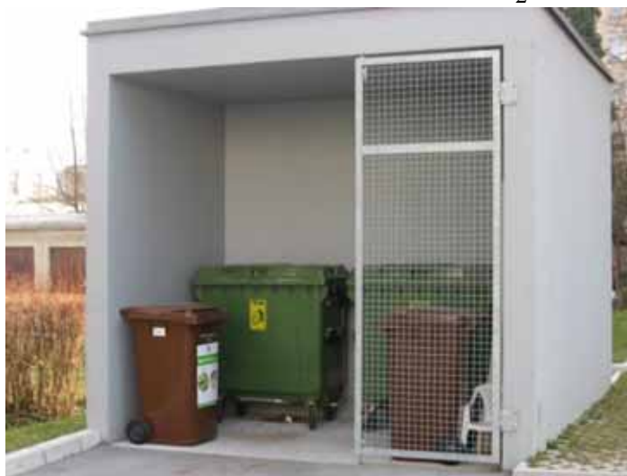
3 Prostor za zabojnike v Kajuhovi ulici, 2008 Foto: Mojmir Mosbrucker
