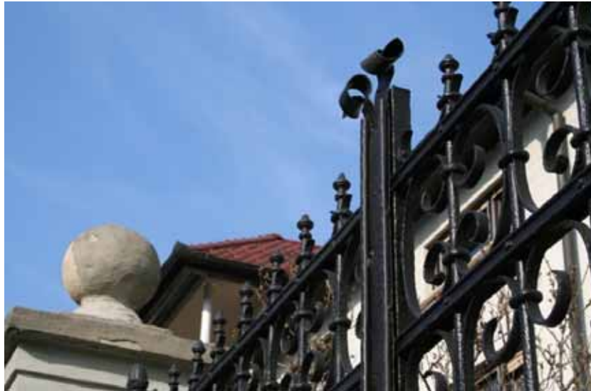
13 Detajl z ograje v Ipavčevi ulici, 2008 Foto: Špela Hribernik
