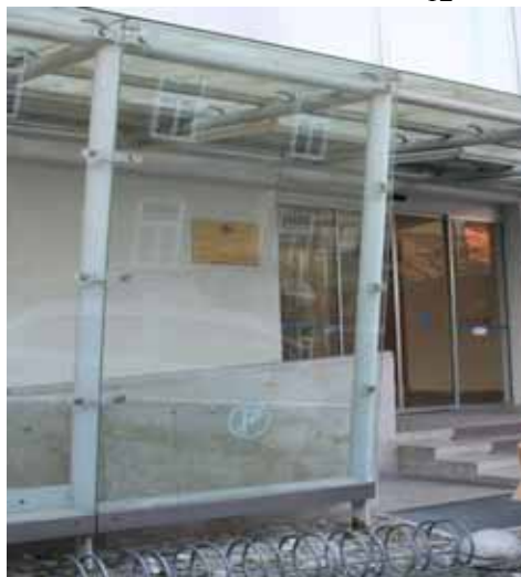
14 Vetrolov in klančina - vhod v Osrednjo knjižnico Celje na Muzejskem trgu, 2008 Foto: Špela Hribernik
