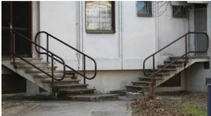
13 Stopnice ob policijski zgradbi v Ipavčevi ulici, 2008 Foto: Špela Hribernik
