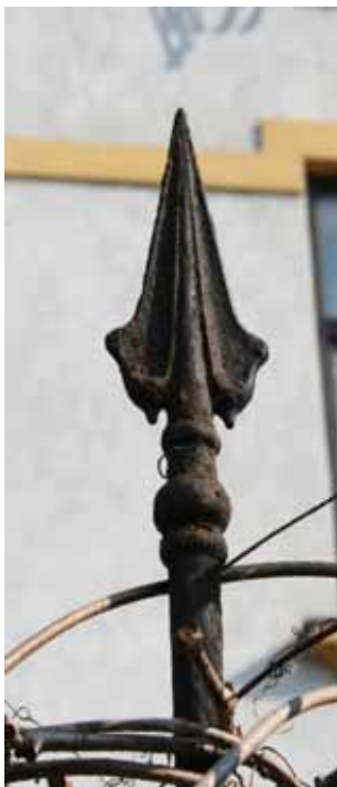
8 Detajl z ograje v Ipavčevi ulici 14, 2008 Foto: Špela Hribernik
