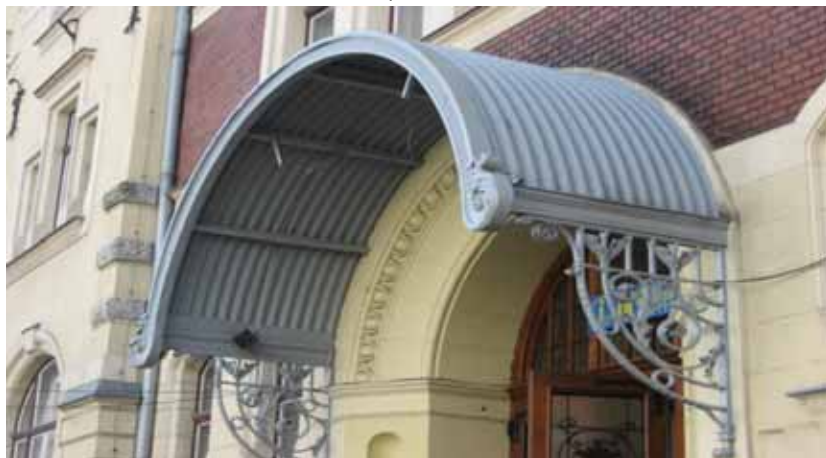
9 Nadstrešek nad vhomom v Celjski dom, 2008 Foto: Špela Hribernik
