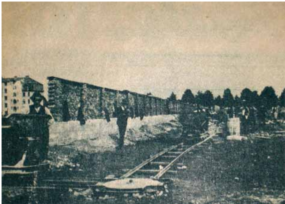
Gradnja zidu okoli stadiona Vir: Ilustrirani Slovenec , 18. okt. 1925, str. 2.
