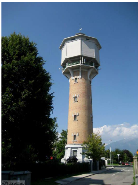
Slika 6: Vodni stolp, Kranj.
