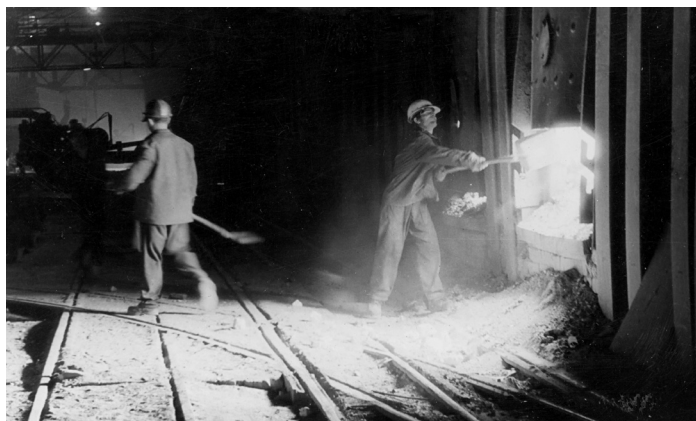
Dodajanje primesi v Siemens-Martinovo peč leta 1971, hrani GMJ
