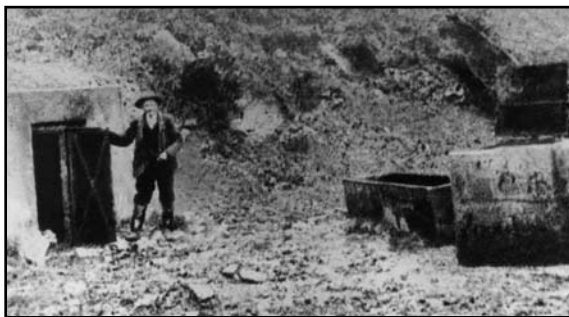
Gradnja vodnega zbiralnika nad Murovo (Fototeka GMI)
