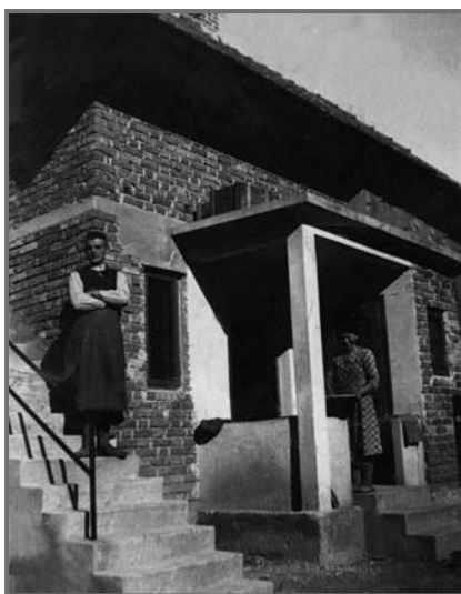
Gradnja Urhove hiše (Stanko Urh)
